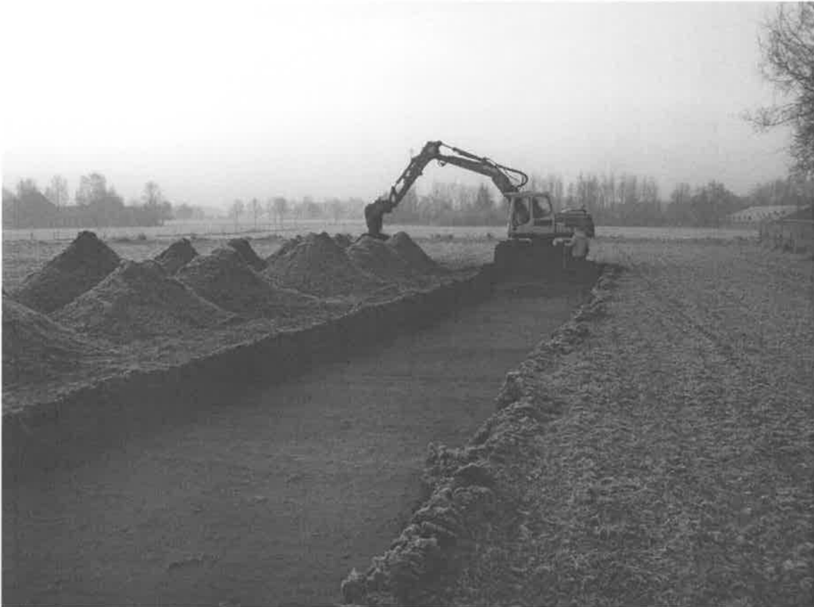
Afb. 4. Didam Westelijke Randweg, aanleggen van een proefsleuf.
