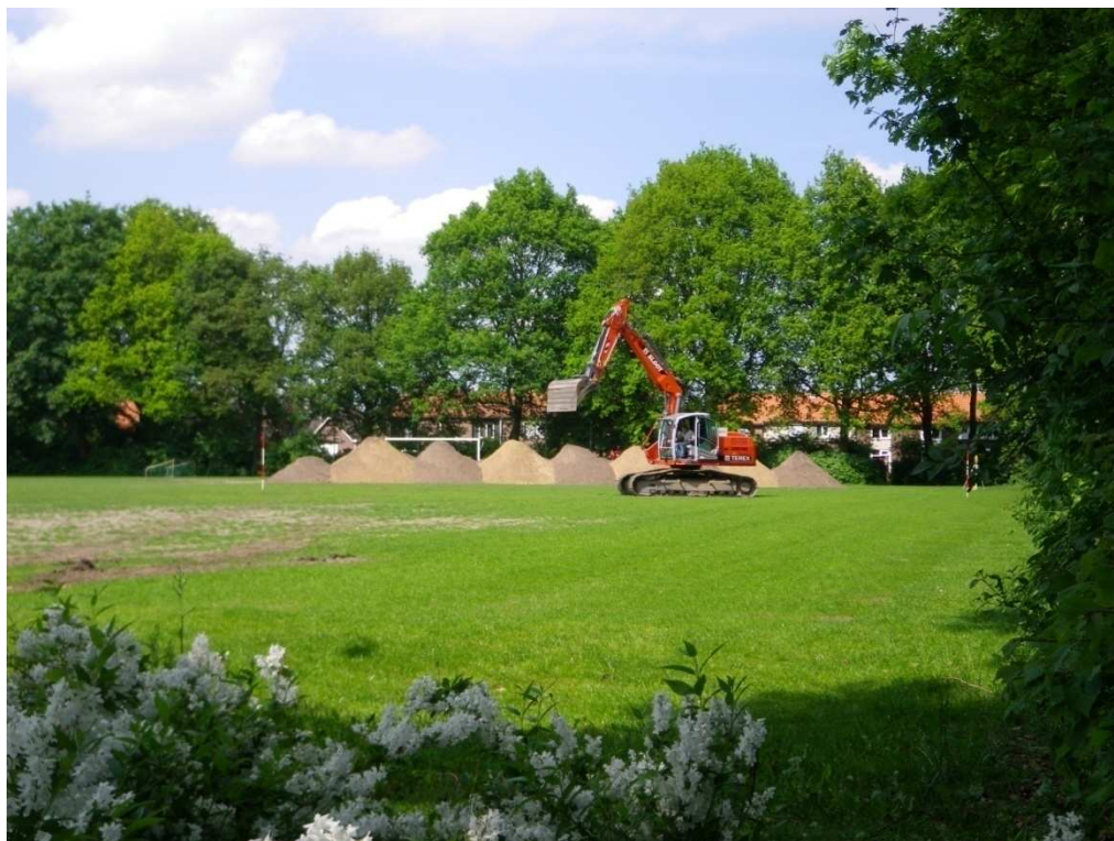
Fig. 1.1: Plangebied bij aanvang van de werkzaamheden.
