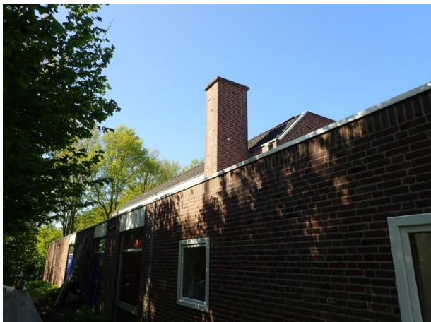
Foto 5: links, zijkant van de sporthal met in de muur open stootvoegen en bij de schoorsteen loodslabben.
