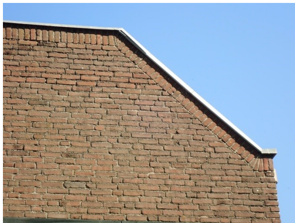
Foto 5: links, zijkant van de sporthal met in de muur open stootvoegen en bij de schoorsteen loodslabben.
