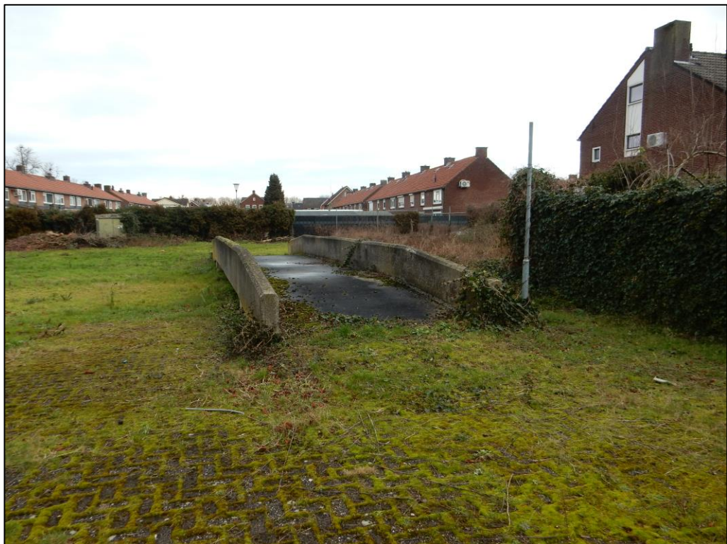
Figuur 3 Fotografische indruk van de betonnen brug. Deze zal verwijderd worden in de beoogde ontwikkeling.
